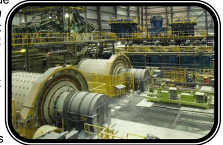
Installations de la Mine Québec Lithium (SESAT, 2013)
