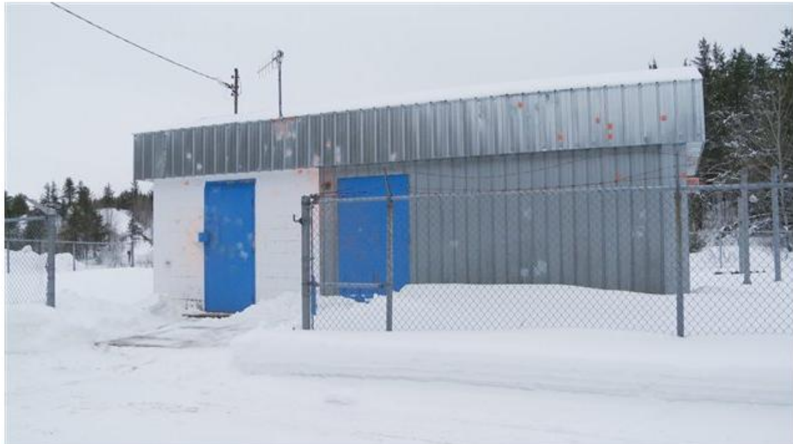
Deux puits d'eau potable à Malartic. Photo : Claude Bouchard
