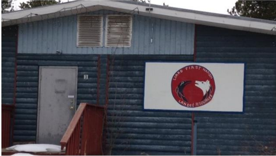
La Première Nation Liard compte 40 puits artésiens privés ainsi qu'une usine de traitement de l'eau. Photo : ICI Radio-Canada/Karen McColl
